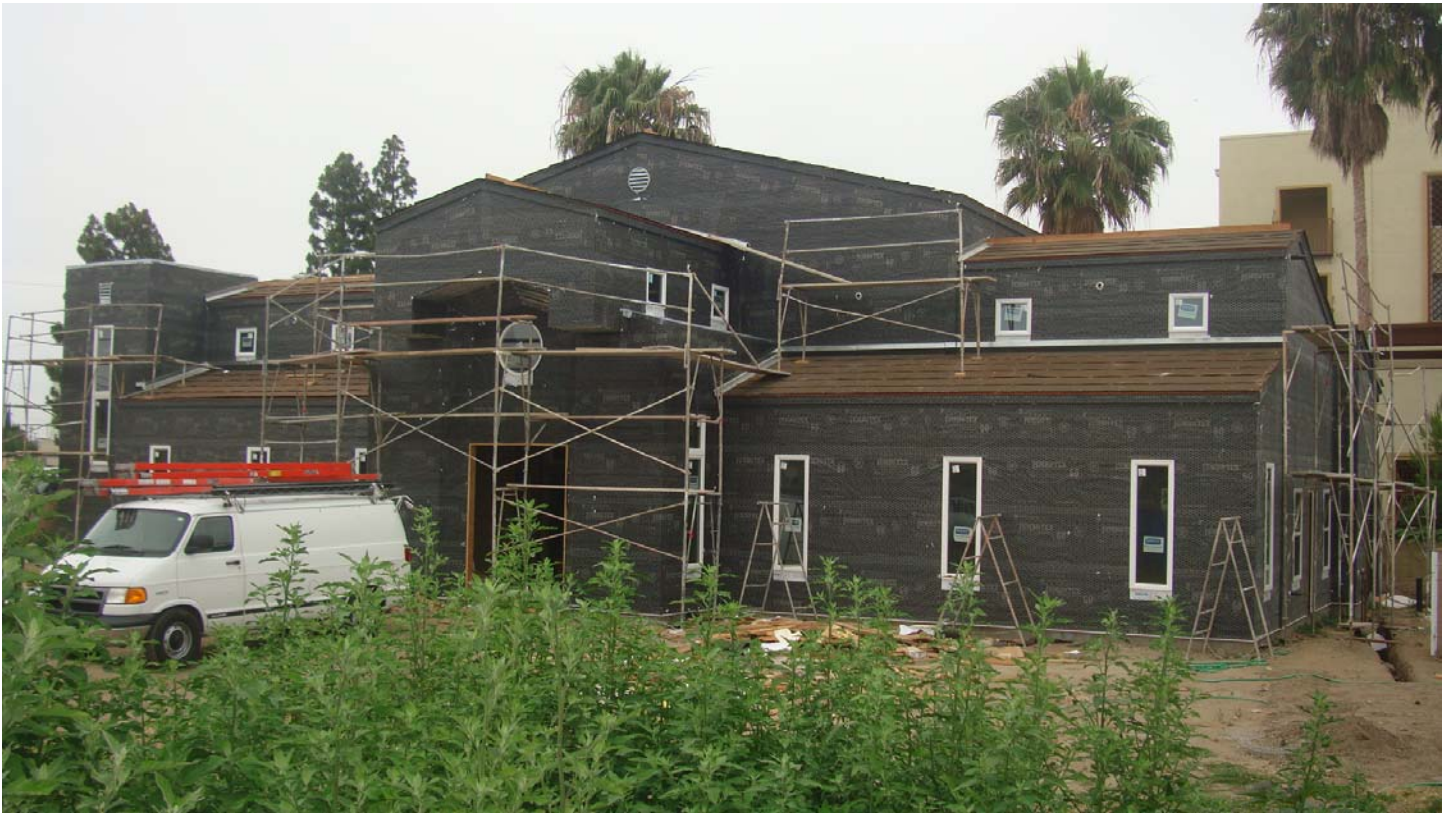
Hình chụp phía mặt sau Trụ Sở
