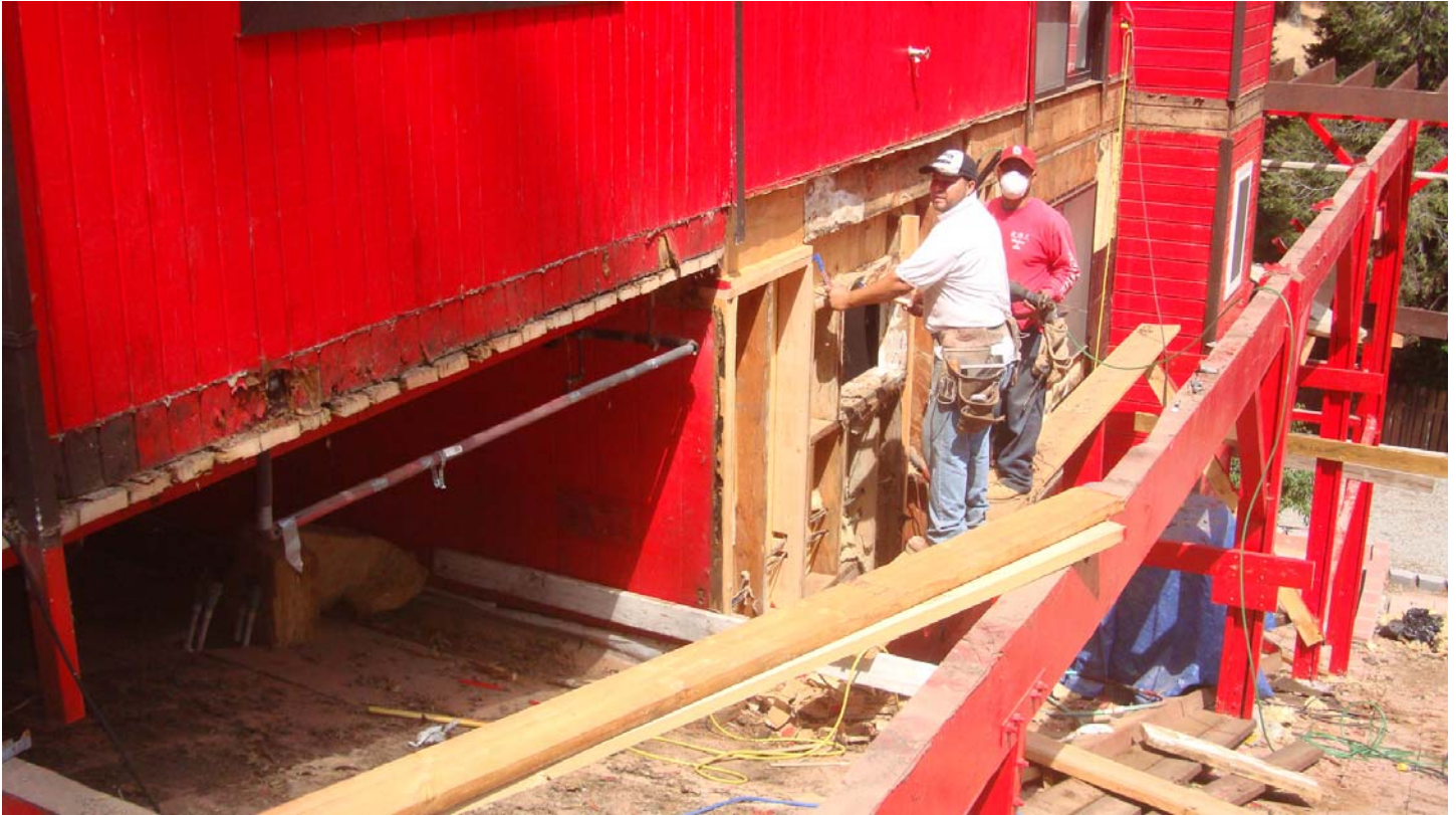
Đây là vách phía sau phòng nhà bếp đi ra, sẽ cắt một đoạn bị hư mục.
