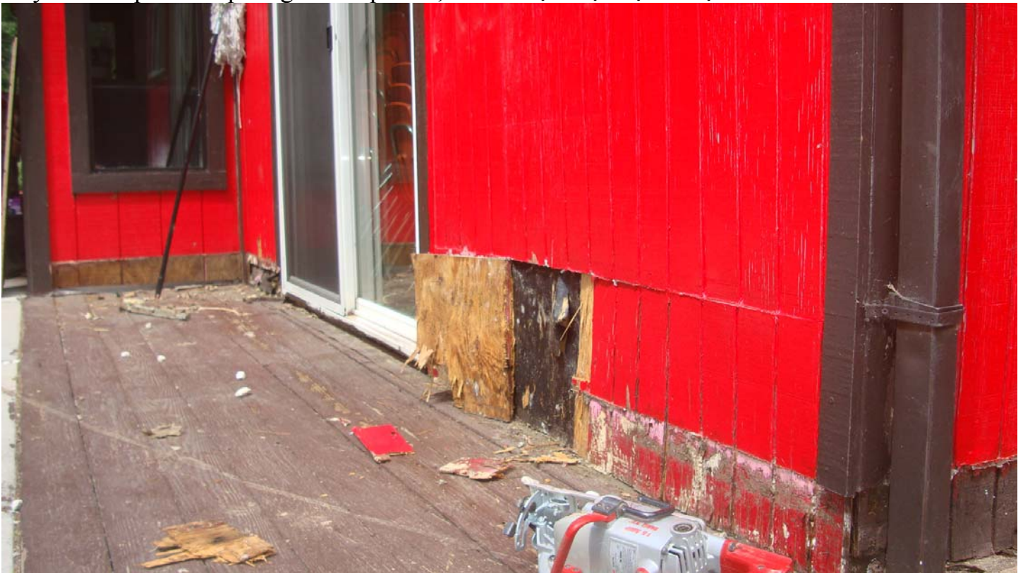
Dưới đây là mặt trước, những vách màu còn trắng là đã được thay gỗ mới, và những cây đà mới của sàn gỗ
